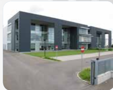
Galtech Site Cavriago (RE) • Italy
